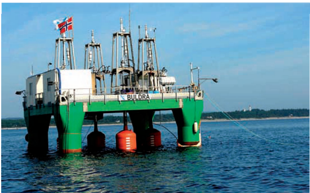
■ FO 3 een punt-absorptiesysteem ontwikkeld in Noorwegen (SEEWEC)
