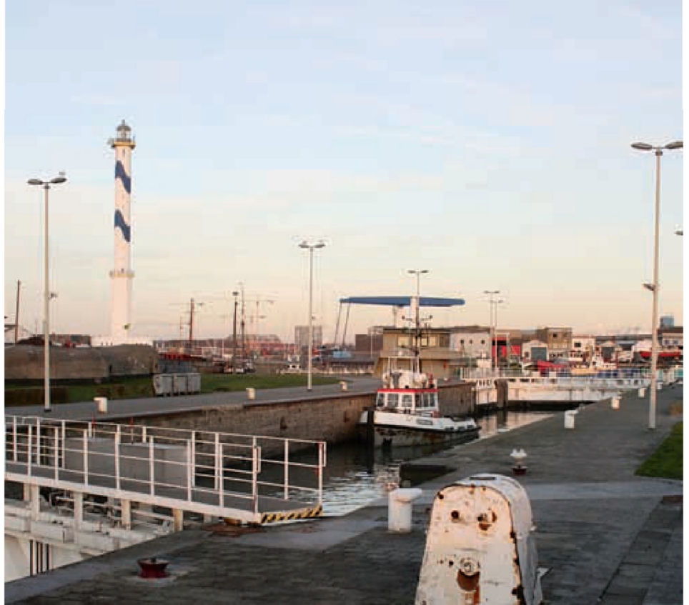
■ De Visserijsluis, die het Visserijdok te Oostende verbindt met de havengeul, is uitgerust met twee paar puntdeuren. Door deze sluis is de achterliggende vissershaven getijvrij (VL)
