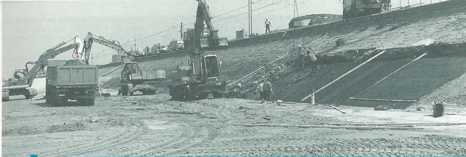
WWK Herstelwerkzaamheden aan de dijk van Raversijde
