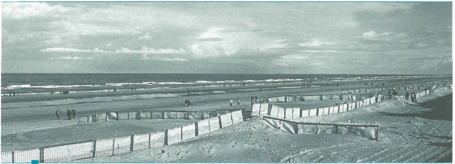
WWK Met zandvangens worden ongewenste verplaatsingen van zand door de wind zoveel mogelijk tegengehouden
