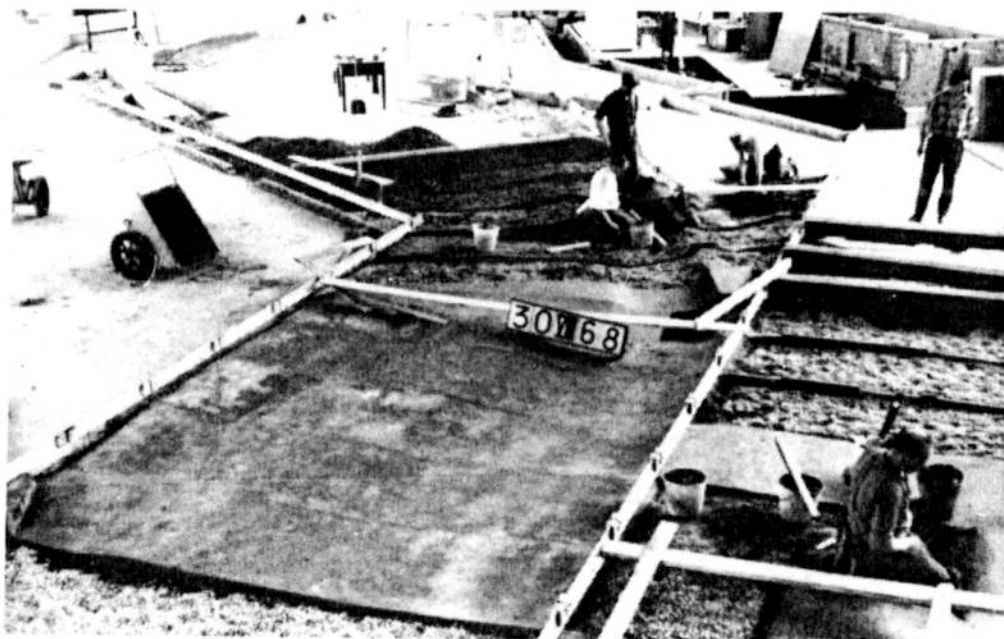
Photo 2 : Achèvement du lit entre profils
