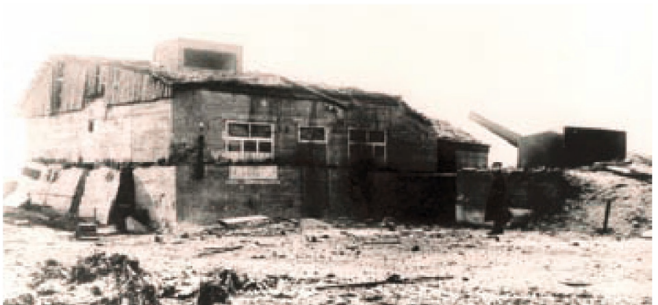
■ Batterij Oldenburg kan gerust een voorbeeld genoemd worden van goede camouflage. Hier zien we één van de bunkers, gecamoufleerd als boerderij. Op het beton werden ramen en deuren geschilderd, bovenop werd een zadeldak gebouwd. Bemerkt rechts op de foto één van de stukken geschut (CDH Evere, Foto Massot)
