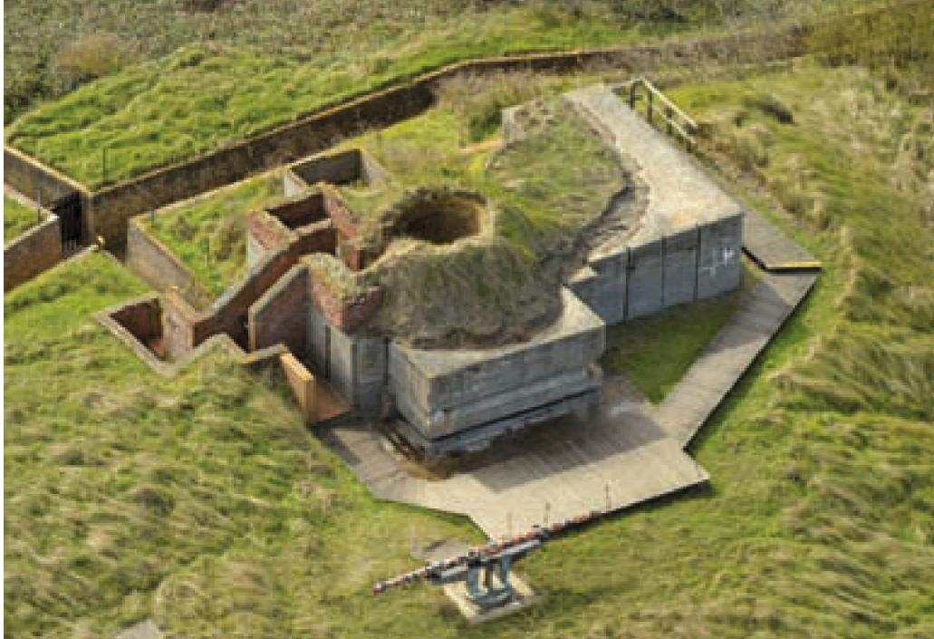
■ De observatie- en commandobunker van batterij Aachen, met daarnaast de telemeter, die zich zeker tijdens een deel van de oorlog op het dak van deze bunker bevond. Het maakt nu deel uit van het openluchtmuseum Atlantikwall (Raversijde). De bakstenen constructies werden door de Duitsers gebouwd tijdens de Tweede Wereldoorlog, toen enkele bunkers van de batterij geïncorporeerd werden in de Atlantikwall (Yves Adams, Provincie West-Vlaanderen)
