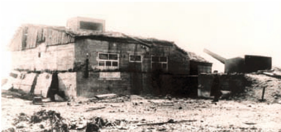
■ Batterij Oldenburg kan gerust een voorbeeld genoemd worden van goede camouflagé. Hier zien we één van de bunkers, gecamoufleerd als boerderij. Op het beton werden ramen en deuren geschilderd, bovenop werd een zadeldak gebouwd. Bemerkt rechts op de foto één van de stukken geschut (CDH Evere, Foto Massot)
