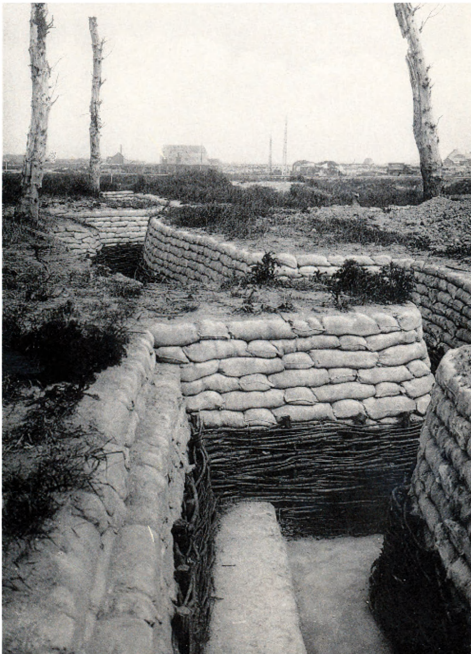
■ Het Redan in Nieuwpoort in de "gerestaureerde" versie. Van de originele relictten blijft niets meer over (Privé collectie)
