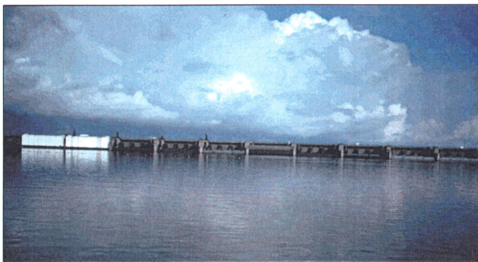
Figuur 5. Meetlocatie Haringvlietsluizen
