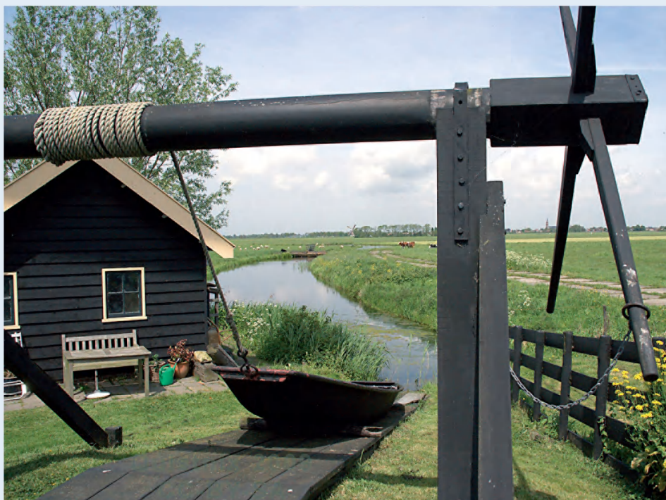
■ Deze moderne overtoom in het Hollandse Rijnwetering geeft mooi aan hoe deze voorloper van het sas functioneerde om kleinere schepen met platte bodem verschillen in waterniveau te laten overbruggen (wikimedia)
