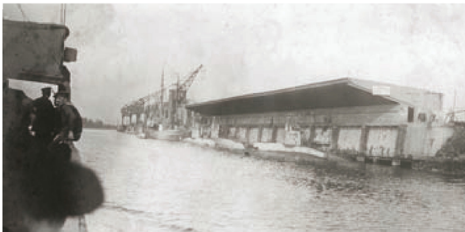
■ Ein Torpedoboot passiert einige festgemachten U-Boote der Klasse UB-I im „Achterhaven“ (der mehr landeinwärts gelegene Hafen) von Brügge. Mittels Betonkonstruktionen und hölzerner Überdächer waren sie einigermaßen vor möglichen Luftangriffen geschützt (Tomas Termote)
