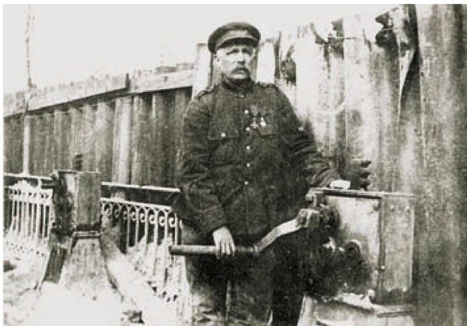
Hendrik Geeraert pose près de l'un des crics permettant de manœuvrer le déversoir du canal Noordvaart (Collection Callanaere-Dehouc)
