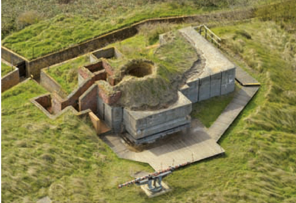
■ Der Beobachtungs- und Kommandobunker der Batterie Aachen. Daneben ein Entfernungsmesser, der im Krieg sicher eine Zeit lang auf dem Dach dieses Bunkers gestanden hat. Er befindet sich im Freilichtmuseum Atlantikwall (Raversijde). Die deutschen Truppen haben die Backsteinkonstruktionen im Zweiten Weltkrieg errichtet, als einige Bunker der Batterie in den Atlantikwall integriert wurden. (Yves Adams, Provinz Westflandern)
