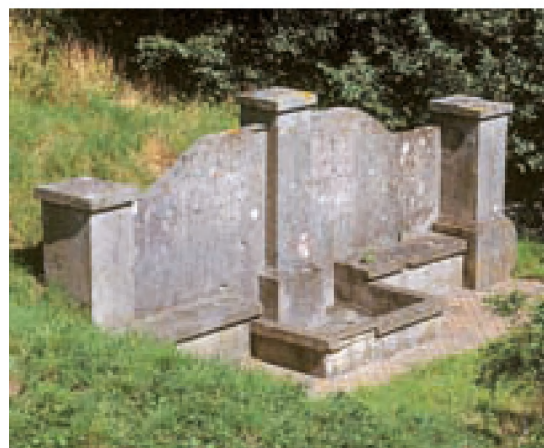
■ Der Name des „Barbara Brunnen“ verweist auf die Schutzheilige der Artillerie. Er war einer der drei Brunnen der Batterie Aachen aus dem Ersten Weltkrieg. Der Name stand damals in großen Buchstaben auf dem Monument. Der Brunnen ist jetzt Teil des Freilichtmuseums Atlantikwall (Raversijde) (Jeroen Cornilly, Provinz Westflandern)
