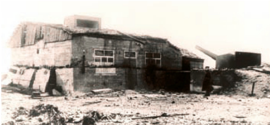
■ Die Batterie Oldenburg kann als Beispiel für eine gute Tarnung gelten. Hier sehen wir einen der Bunker, der als Bauernhof getarnt wurde. Auf den Beton hat man Türen und Fenster gemalt und darüber ein Satteldach errichtet. Rechts auf dem Foto ist eines der Geschütze zu sehen. (CDH Evere, Foto Massot)
