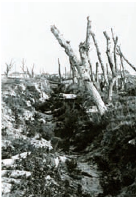
Die belgischen Stellungen der Pfeilschanze von Nieuwpoort im ursprünglichen Zustand (1919) (Privatsammlung)
