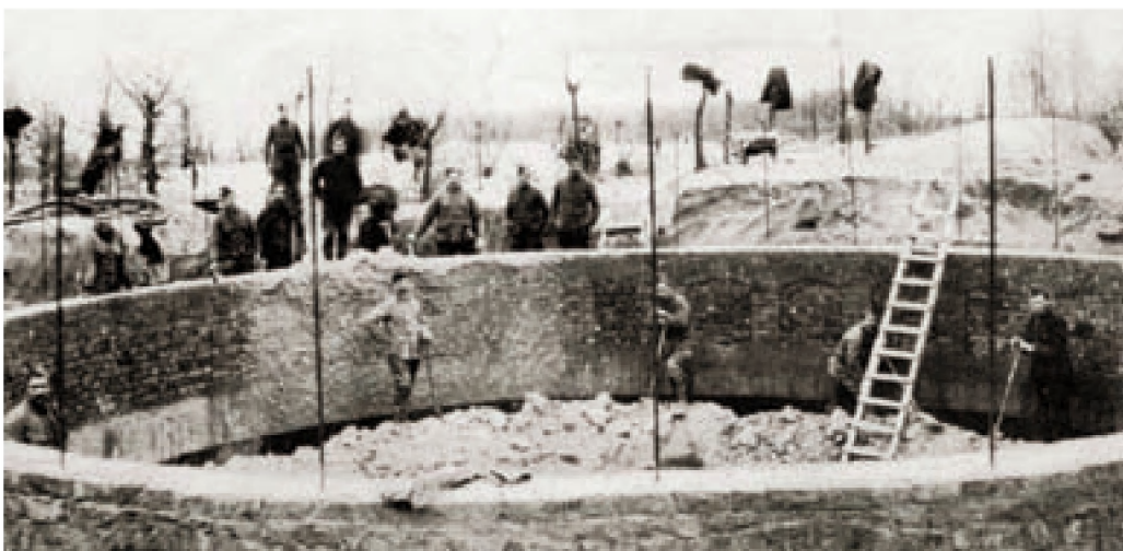
■ La construction du puits collecteur au cours de l'hiver 1917-1918 (Archives Walter Lelièvre, Ramskapelle)
