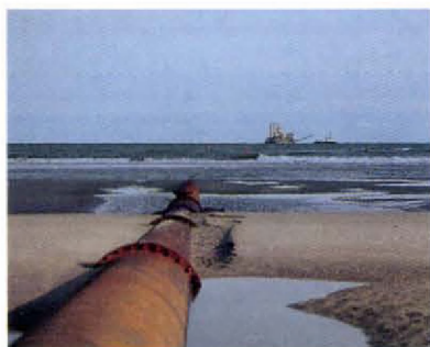
Foto 31 Voor zandsuppleties wordt het zand niet meer uit de Waddenzee maar uit de Noordzee gehaald.
