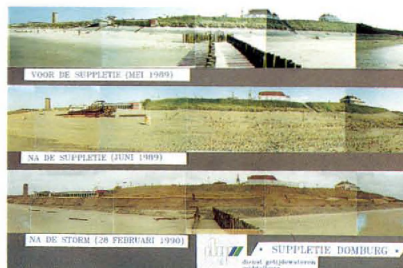
Foto 8. Zandsuppletie en kustafslag bij Domburg. Na de storm van februari 1990 is het zand voor een groot deel verplaatst van het duin naar de vooroever. Ook op deze plaats zorgt het zand voor het minder snel achteruitgaan van de kust.
