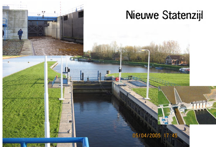
Figuur 8. Overzichtsfoto's sluiscomplex Nieuwe Statenzijl.
