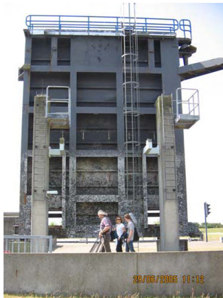
Figuur 11. (Reserve)sluisdeur Bergse Diepsluis. Onderaan de sluisdeur zijn links en rechts de openingen zichtbaar van de rinketten.
