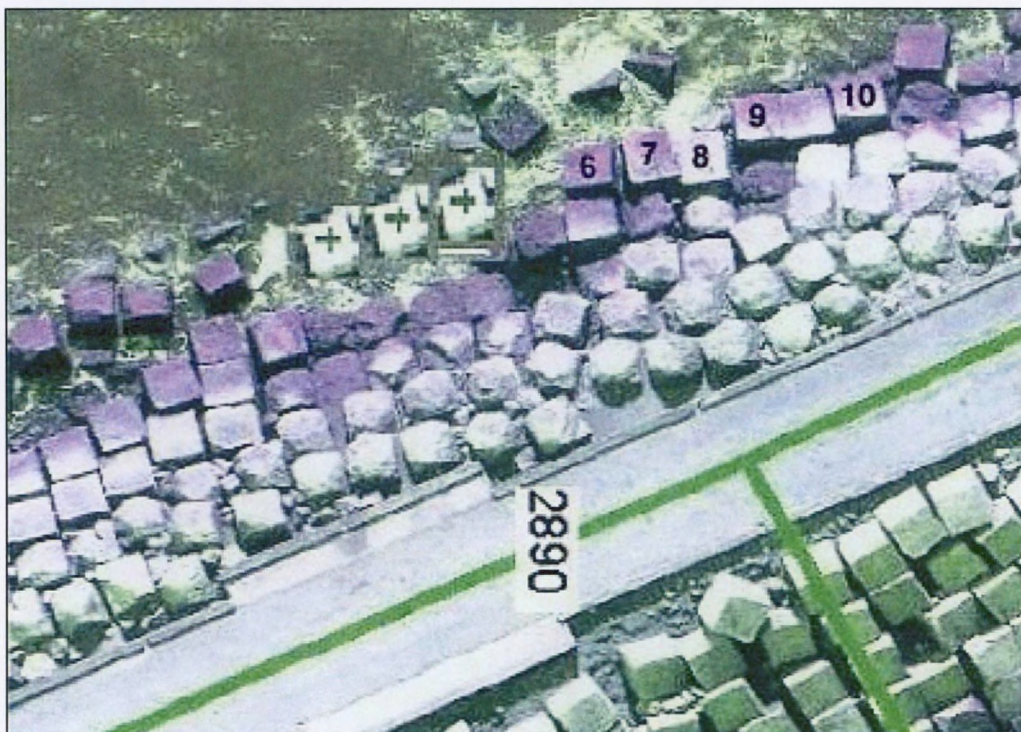
Foto 2. Ligging (oude) blokken 6 t/m 10. Bewerking luchtfoto RWS/TDN Emmen. Er zijn ook blokken met een + gemarkeerd. Dit zijn blokken, die kort na de bemonstering op 26 april zijn bijgeplaatst.
