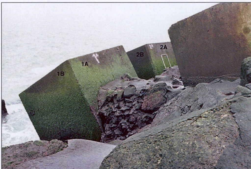
Foto 2. Blokken 1 en 2. Blokken 3, 4 en 5 liggen in het vervolg van blok 2.
