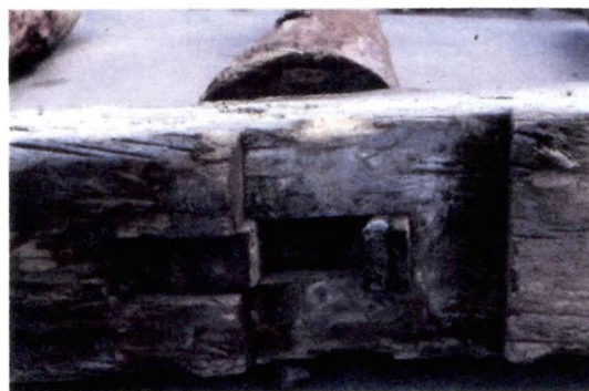
fig 39 Inkeping in een horizontale dwarsbalk waarin een andere horizontale balk paste
