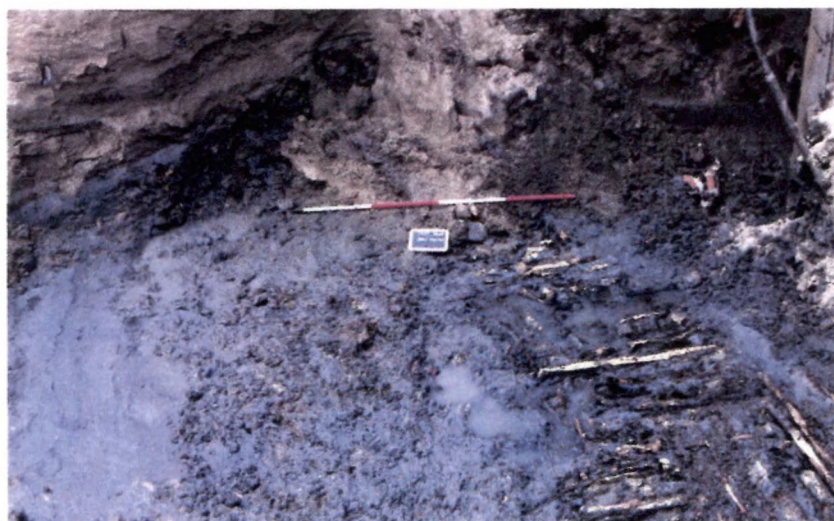
fig 33 Pakketten van de verstevigende onderbouw van een wallichaam
