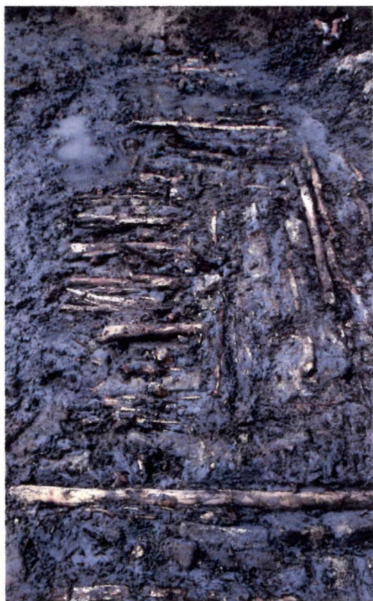
fig 34 Detail van het pakket met takkenmatten en baksteen in de onderbouw van een wallichaam
