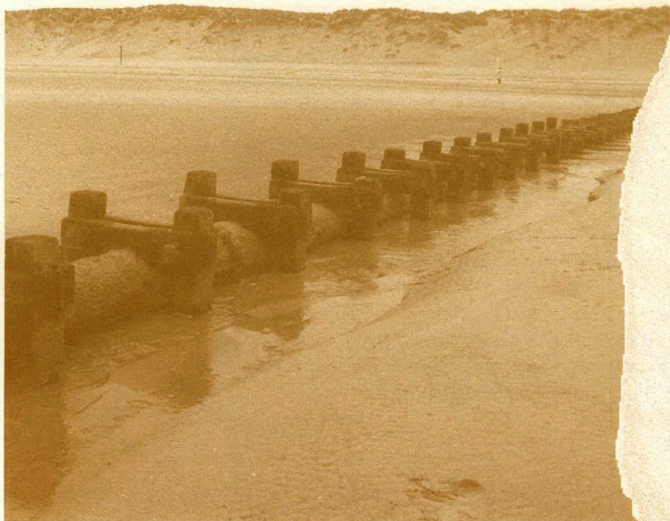
Deze pijp voor afvalwater op het strand van Koksijde werd verwijderd in juni 1995.
