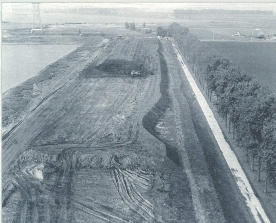
Bouw van landschapsheuvel met rivierslib. (uit: Beleidsplan Sanering Waterbodembeneden Zeeschelde, Ministerie van de Vlaamse Gemeenschap, Departement Leefmilieu en Infrastructuur)
