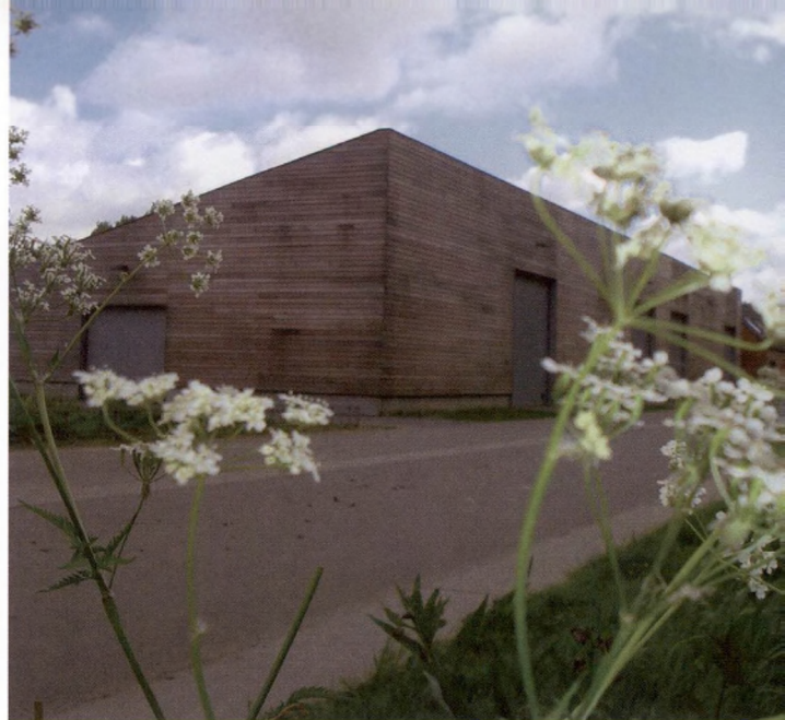
Bij de vernieuwingswerken van het dienstgebouw in De Gavers werd heel wat aandacht besteed aan de inpassing van het gebouw in het landschap.
