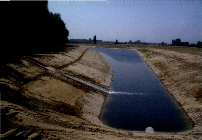
Het waterspaarbekken in Ardoorie, tijdens en na de werken.
