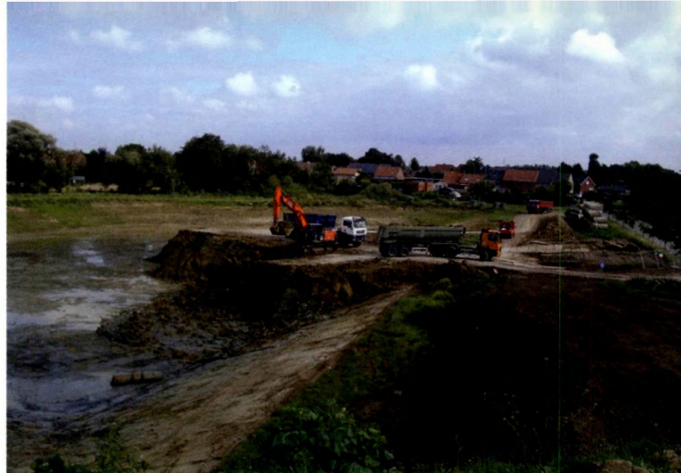
Werken aan het waterspaarbekken in Vlamertinge.
