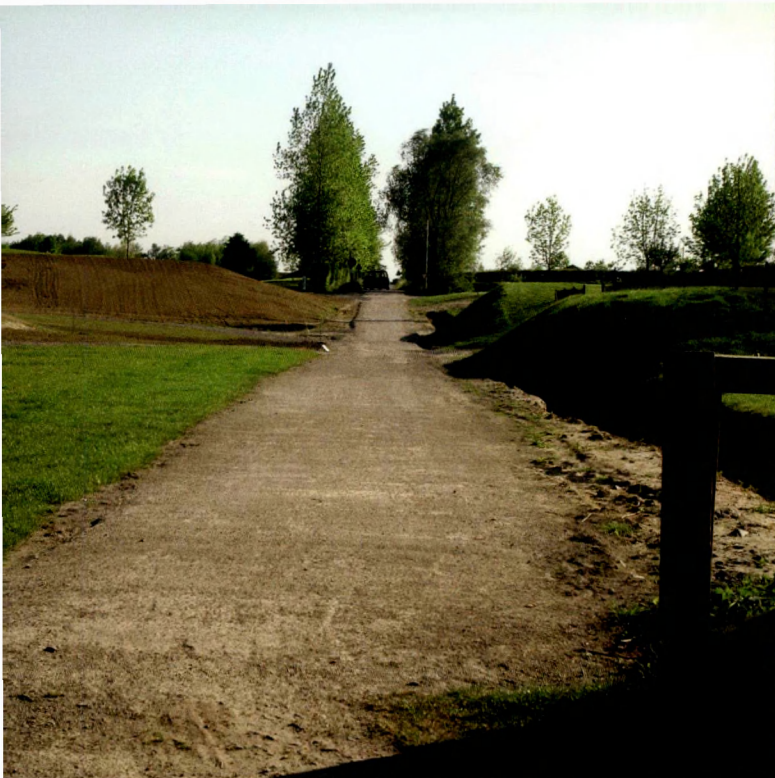
Het vernieuwde fietspad langs het golfterrein aan De Palingbeek.
