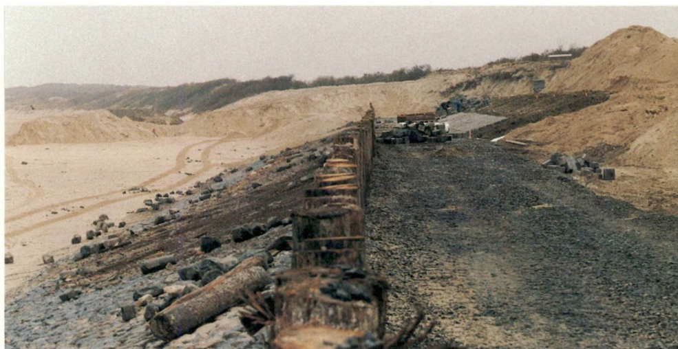
Foto 1.A. De dijk aan Nederlandse zijde wordt vernieuwd en bekleed met basaltblokken. (17 dec. 1990)
