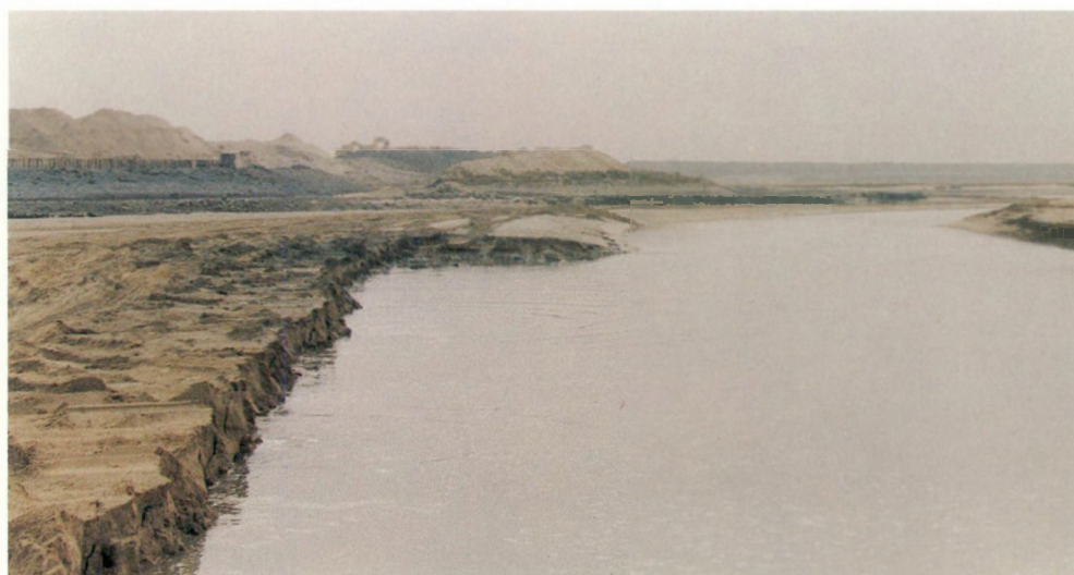
Foto 1.B. Zwinvlakte, noordelijke zandvang. Het uitgegraven zand wordt aangewend voor de verzwaring van de Internationale Dijk op Nederlands grondgebied. (17 dec. 1990)
