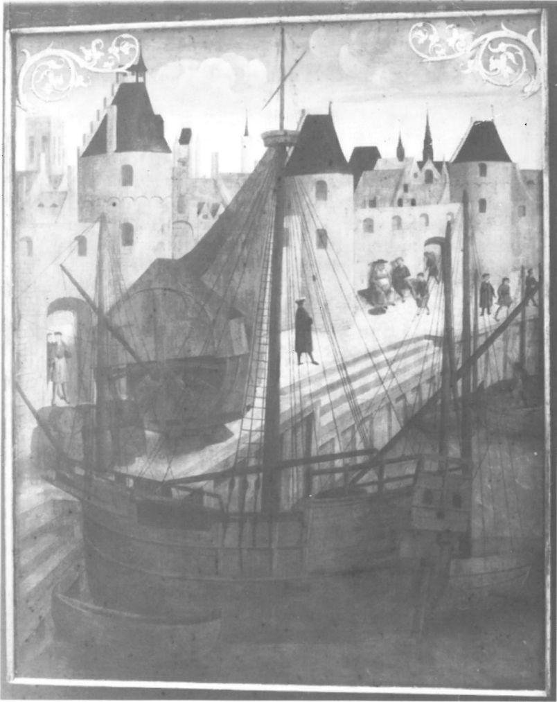
Afb. 5. De draaibare houten havenkraan te Nieuwpoort, opgericht in 1467-1468. Perspectief gezicht op de haven, de kaai en de havenpoorten van de ommuurde stad Nieuwpoort. Tafereel op de keerzijde van een van de zijpanelen van het drieluik met voorstellingen uit het leven van de HH. Antonius en Bernardus. Werk toegeschreven aan de schilder Lanceloot Blondeel, gestorven in 1561. Stad Nieuwpoort, Stadhuis. (Copyright foto Stad Antwerpen, Nationaal Scheepvaartmuseum, Iconografische afdeling, cat. nr. 73.73.6).
