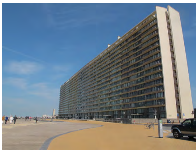
Flat bij Raversijde, waar de boulevard een overmaat heeft gekregen en de openbare ruimte goed is vormgegeven
