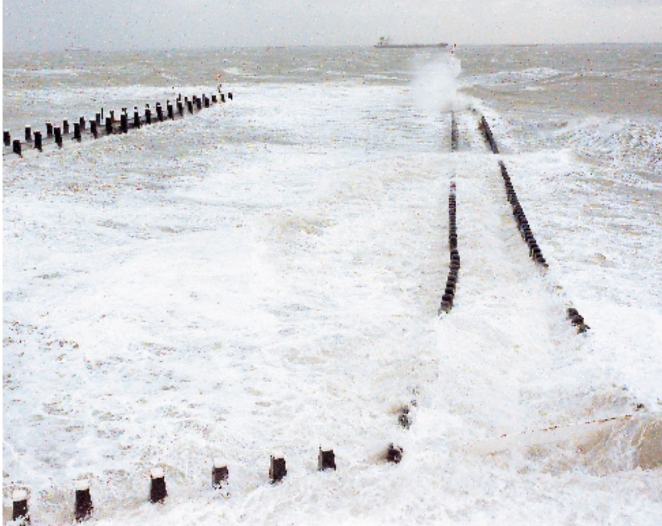
De storm van 6 november heeft in combinatie met het extreem hoge water voor veel overlast gezorgd in verschillende Zeeuwse dorpen. Hier: kust Walcheren met storm en hoogwater bij Vlissingen (m0)
