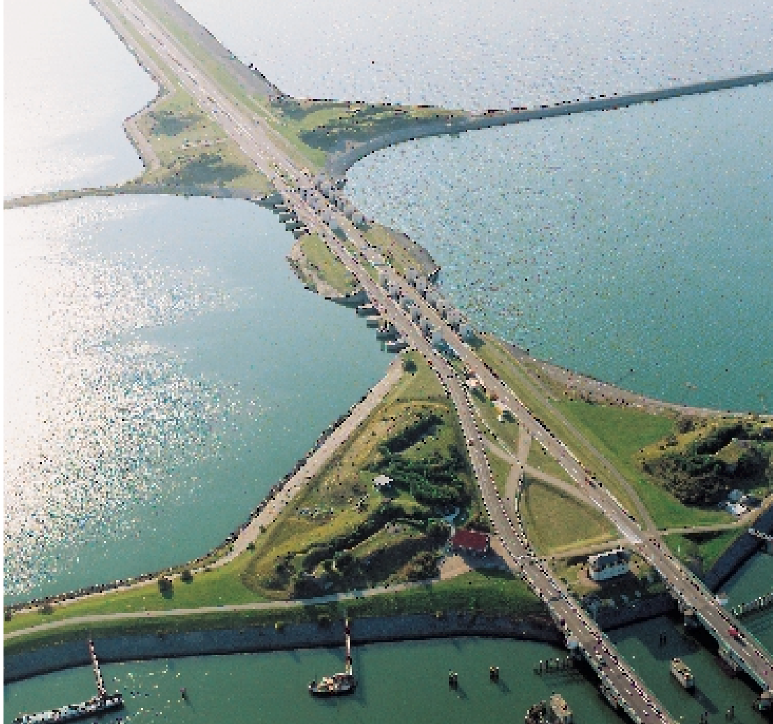
Aanleg afsluitdijk (hier bij Kornwerderzand) zorgde voor vergroting getij-amplitude in de Westelijke Waddenzee (m0)
