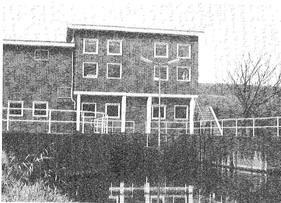
Instroming gemaal Joh. Glerum te Kruiningen
