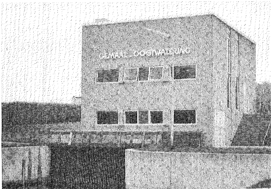
Gemaal Oostwatering (Veere)
