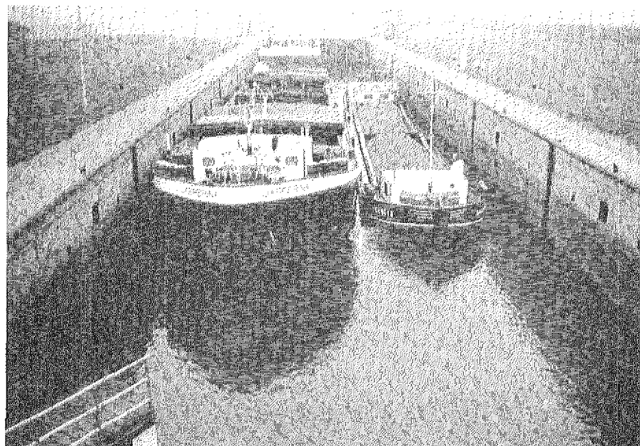
Sluis in de Zandkreekdam
