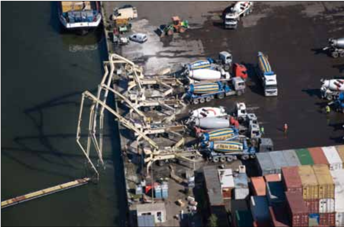
Uitvoering van de betonpompwerken aan het Kanaaldok. 25.000 m 3 mortel en 17.000 m 3 vezelgewapend beton werden gestort in het kanaaldok. Hiermee werd een bescherming aangebracht in het kanaal, om later met de twee Tunnel Boor Machines (TBM's) onderdoor te boren.
