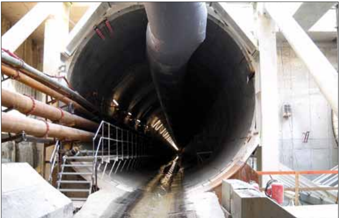
Zicht op één van de twee tunnelkokers.
