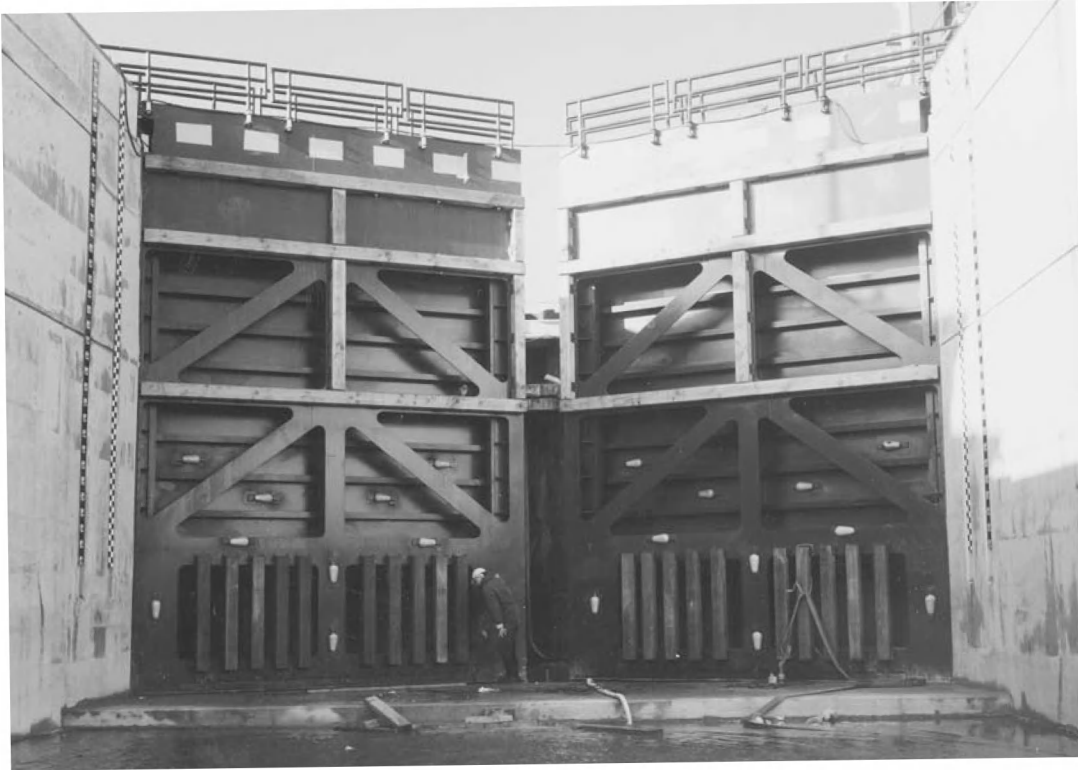
Photo 7.3 Iron mitre gates of Kleine Sluis in IJmuiden (1999)
