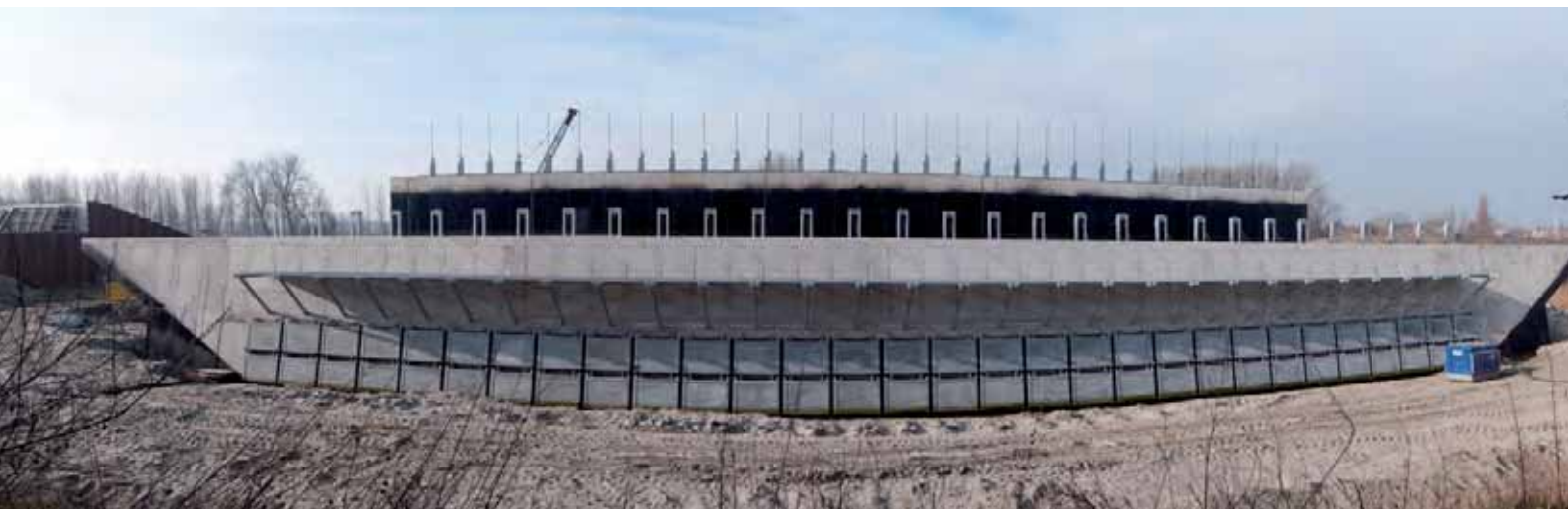
De quasi afgewerkte uitwateringssluis in Kruibeke.
