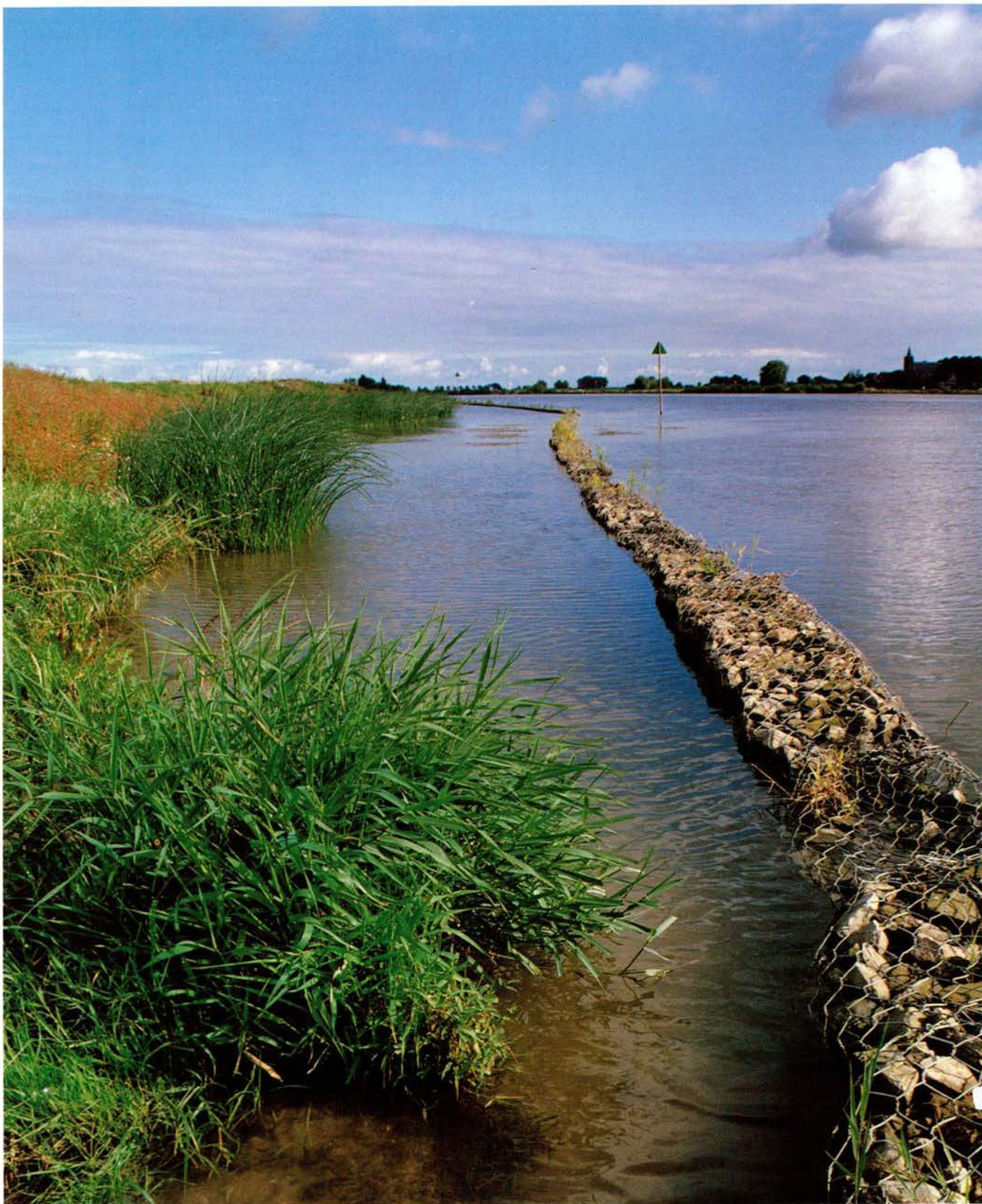
foto : De in 1992 aangelegde vooroeververdediging op de IJssel bij Zande.
