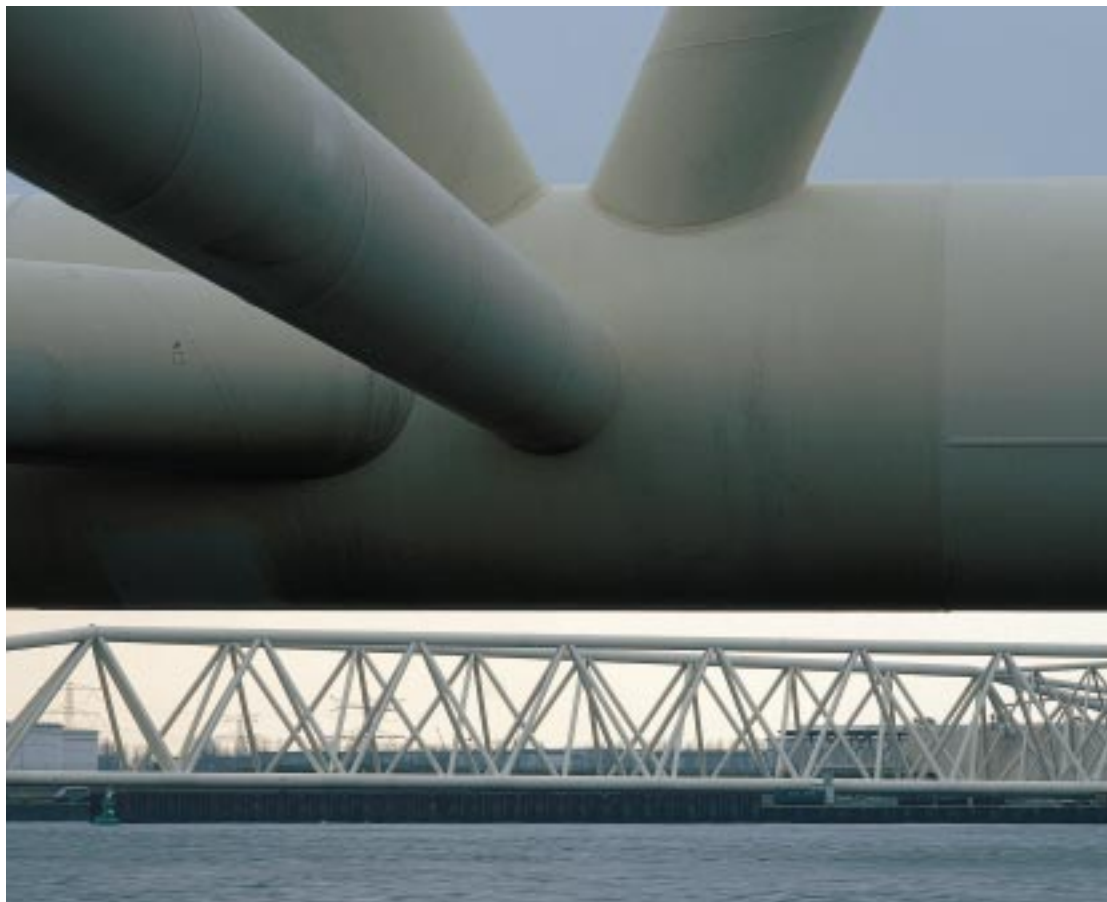
Detail van de recentelijk gebouwde Maeslantkering in de Nieuwe Waterweg (Tineke Dijkstra/rws)
