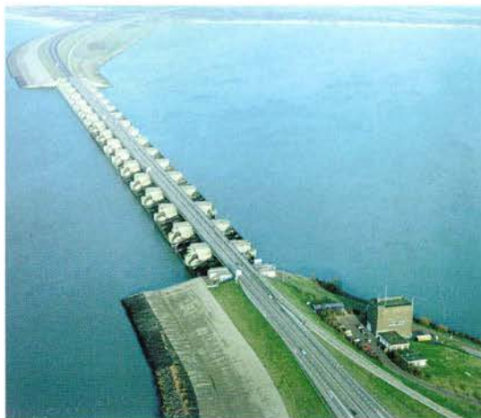
De Haringvlietssluisen spelen een belangrijke rol bij het beheer van de waterhuishouding in het achterland (RIKZ)
