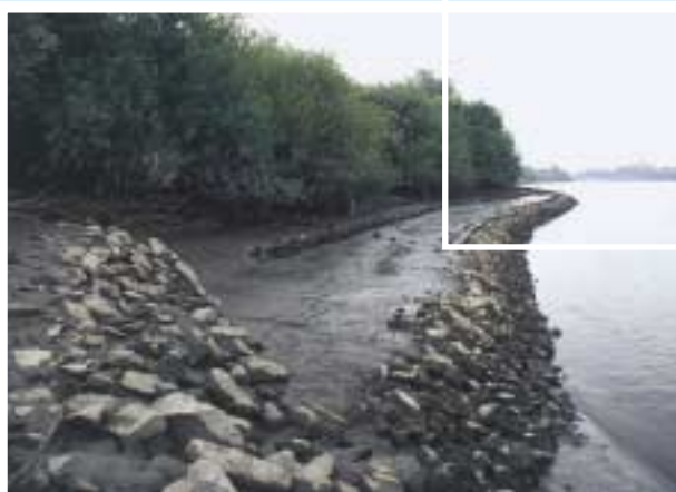
Foto 26 In de Zeeschelde bij Moerzeke-Kastel is terrasbouw toegepast als een milieuvriendelijke schorrandverdediging, bestaande uit parkoepalen en vlechtwerk van wilgentenen. Beoogd werd het steile slik op te delen in terrassen met flauwere hellingen. Hiermee wordt de golfenergie bij het schorklif gebroken maar tevens wordt hierdoor het oppervlak slik vergroot. Het blijkt een degelijk alternatief voor de ecologisch en vooral landschappelijk minder gunstige breuksteenbestoringen (Hoffmann et al, 1997).
