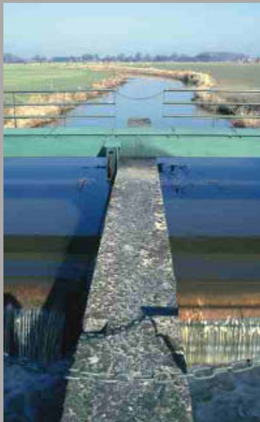
De ruilverkaveling Poederlee bracht naast de rechte trekking van de Aa de aanleg van vier automatische stuwen met zich mee.
