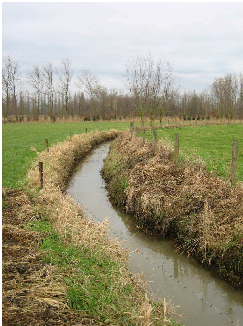
Figuur 62. Zicht op Polderbeek diep uitgegraven en met steile oevers
