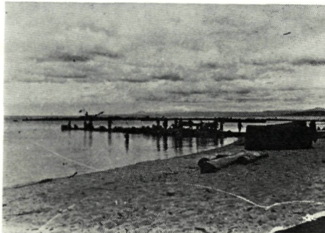
Construction du petit môle qui devait recevoir la coulisse de lancement du « BARON DHANIS ».
