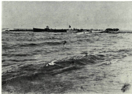
Le môle en construction par gros temps. A quai, le remorqueur « TANGANIKA » en cours de montage.
