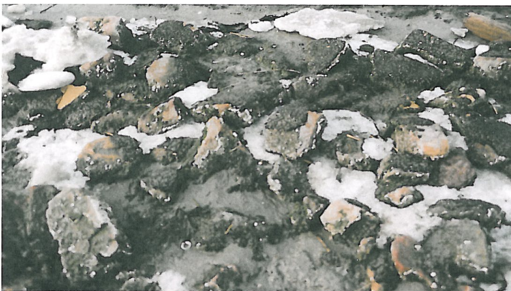
grauwakke ingegoten Hoedekenskerkepolder
