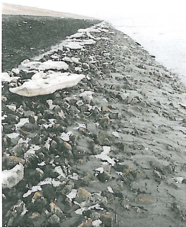
grauwakke ingegoten Hoedekenskerkepolder
