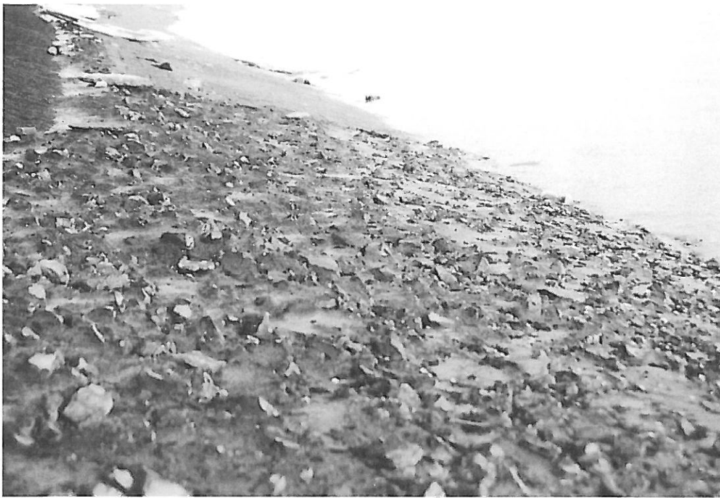
stortsteen ingegoten Hoedekenskerkepolder
