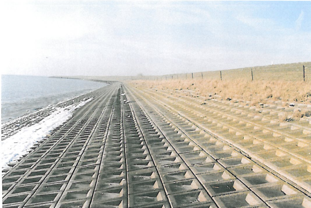
haringman betonblokken Borsselepolder
