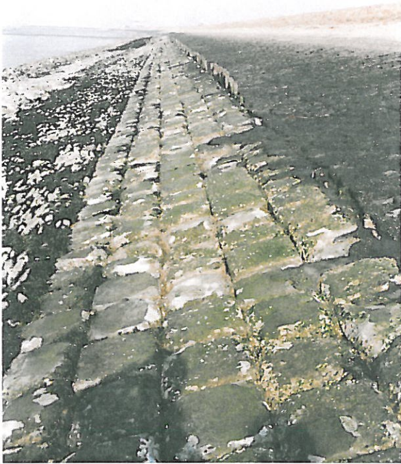
betonblokken in het werk gestort Kruiningenpolder
