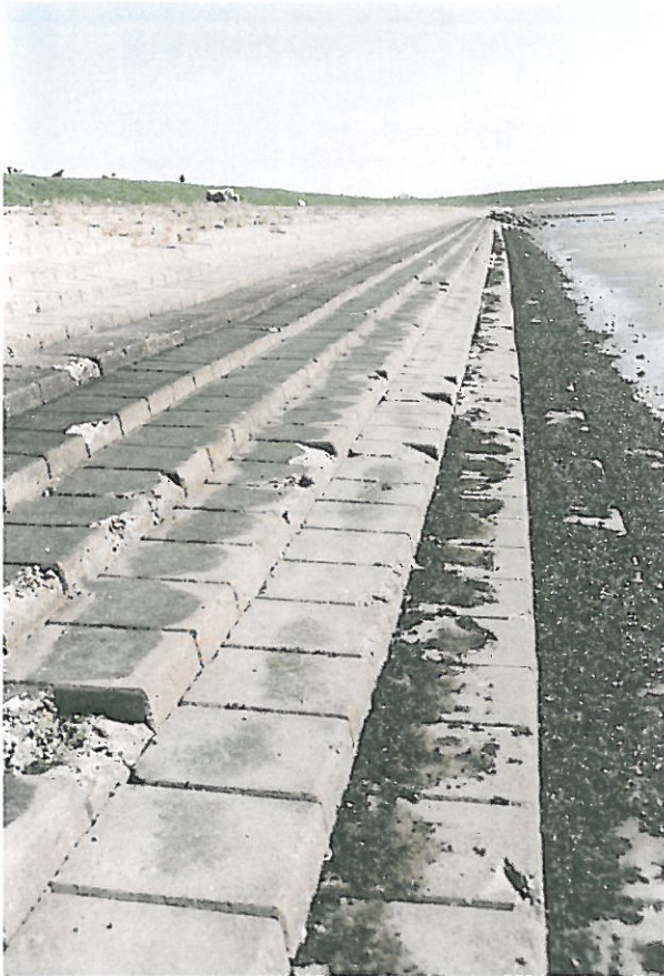
betonblokken systeem Leenderse Oostersteijn
