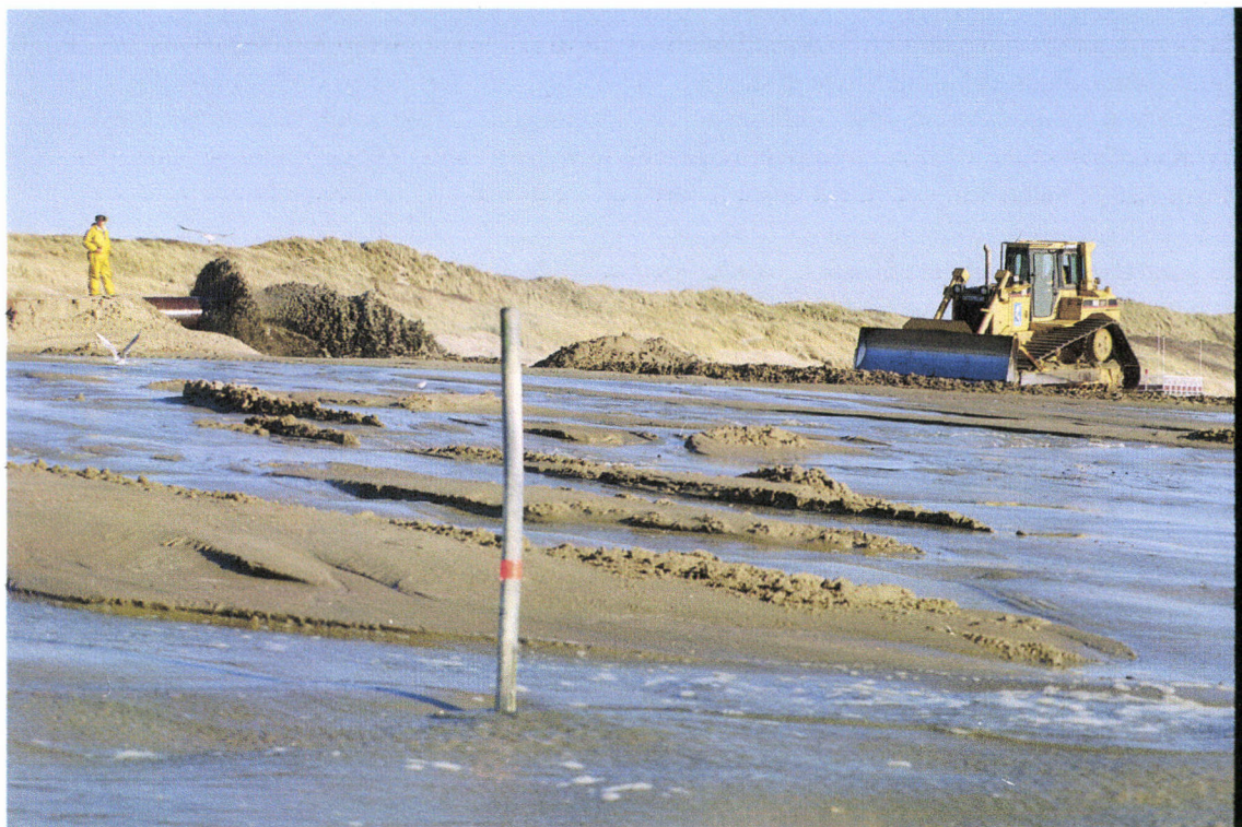
Figuur 3.8 . Strandsuppletie: bulldozer op zandstort
