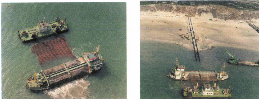
Figuur 3.10. Aanbrengen zinkstuk.
