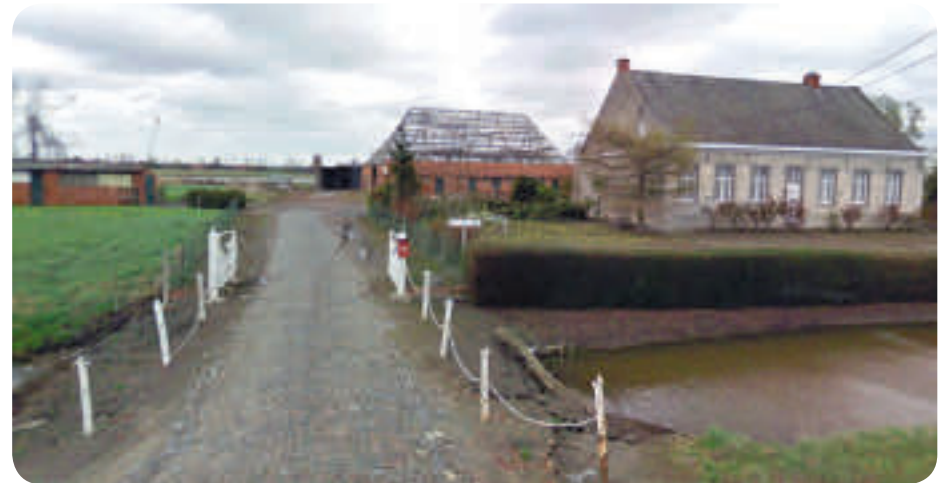
Figuur 5: foto site Hof ter Walle (Google Street View maart 2010)
