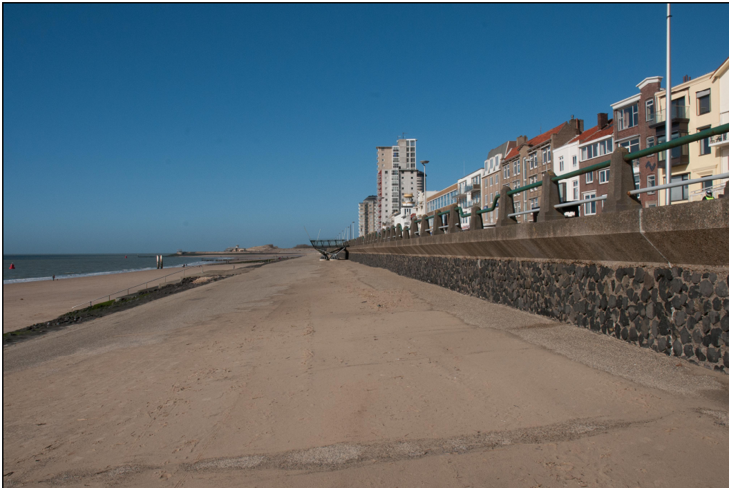
Figuur 27: Keermuur met parapet boulevard Vlissingen
