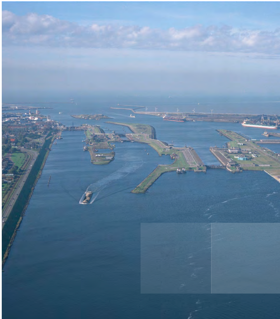
Figuur 29: De sluizen bij IJmuiden
