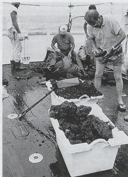
FIG. 5 (à gauche). — Remontée de la drague Waren sous l'œil vigilant de B. RICHER DE FORGES. Remarquer la forte cotte de mailles métalliques qui protège le sac en filet (Photo J.-L. MENOU, ORSTOM).
