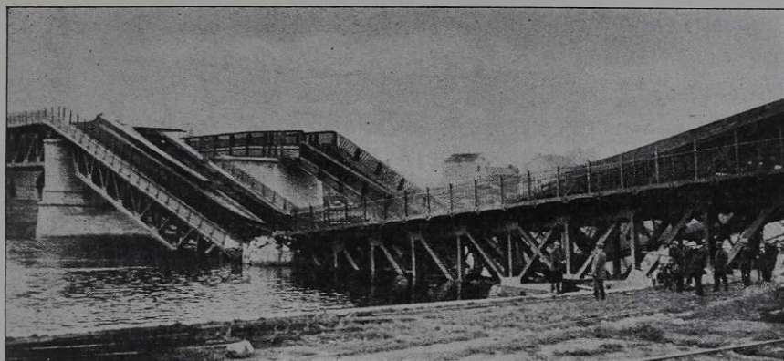
PONT DU CHEMIN DE FER DU LUXEMBOURG, A NAMUR, DÉTRUIT PAR LES BELGES
