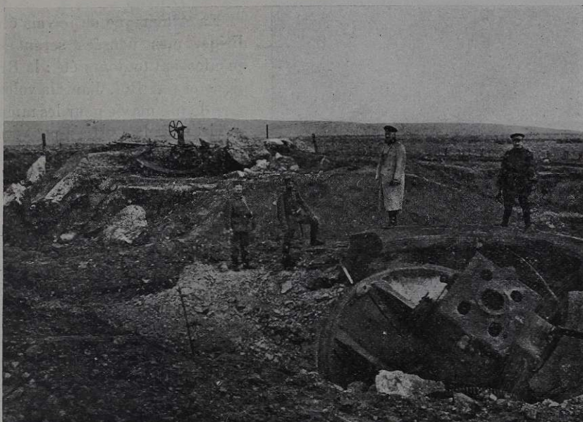
UN DES FORTS DE LIÈGE APRÈS LE BOMBARDEMENT
