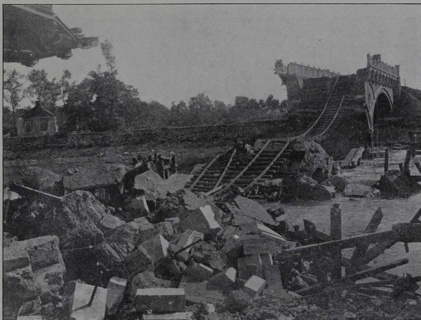
PONT DE DUFFEL, SUR LA NÈTHE, DÉTRUIT PAR LES BELGES
