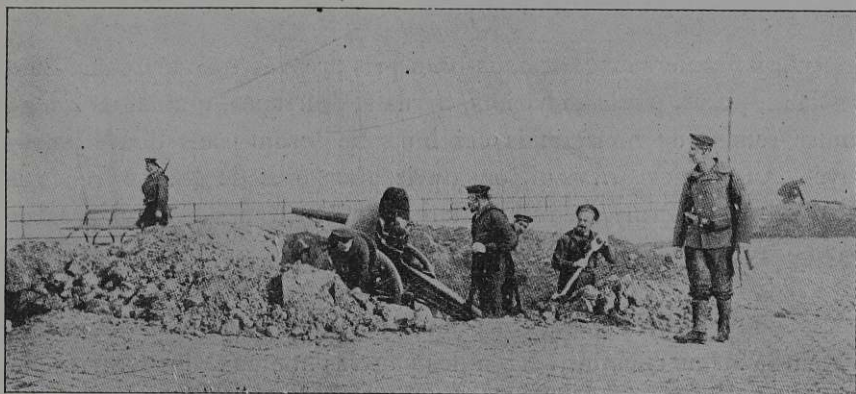
LA « DIGUE DE MER » A OSTENDE, SOUS L'OCCUPATION
