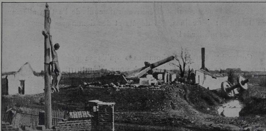
... FERMES, MÉTAIRIES, MOULINS... SONT DÉMOLIS...
