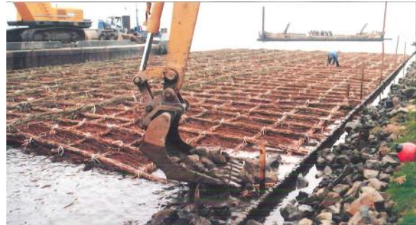
Figuur 4 Een zinkstuk aan een rivieroever bij hoog tij. Met stenen wordt het verzwaard zodat het op de bodem vast komt te liggen en bescherming biedt aan de oever. (bron: VAN 't HOFF (J.), Rijshoutconstructies , p. 44.)
