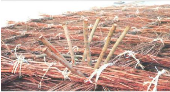
Figuur 3 rijswerk wordt vandaag nog steeds gebruikt voor sommige waterbouwwerken. Hier is een voorbeeld te zien van een zinkstuk. (bron: VAN 't HOFF (J.), Rijshoutconstructies , p. 42.)
