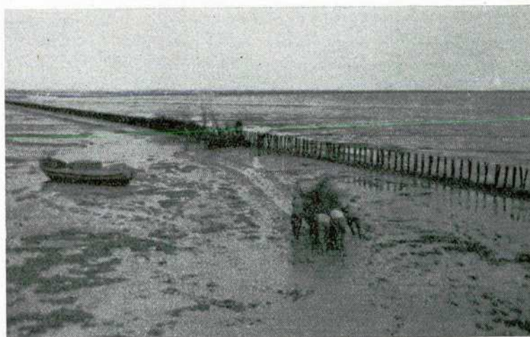
Afb. 3. Een rijzen dam in aanleg nabij de Kaloot in het Zuider-Sloe. Per slikslede wordt het Gelderse rijshout vanaf een schip naar de dam vervoerd en vervolgens tussen de paalrijen verwerkt. Op de ankerak links de stropakken, welke onder het rijshout worden verwerkt als overgangslaag tussen slik en rijshout.
