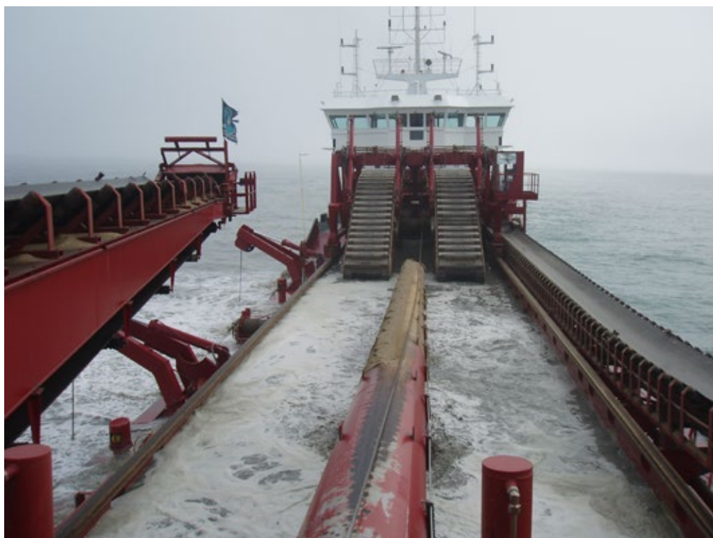
Baggerwerkzaamheden op de Noordzee
