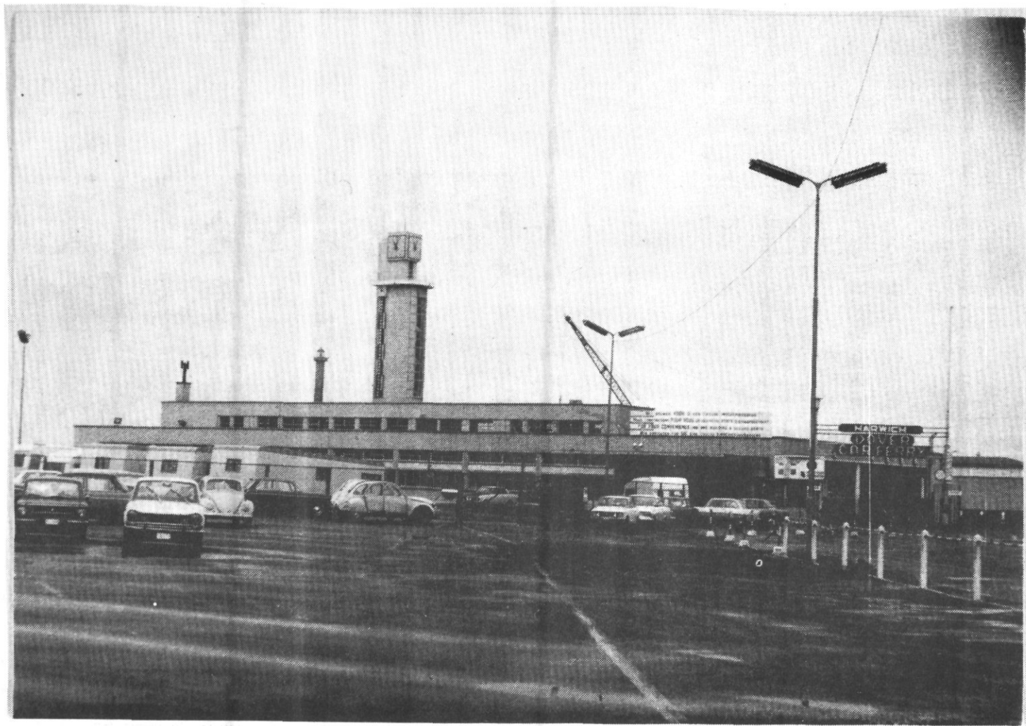
27. 1966 - Uitbreiding van het carferryterrein op het Winston Churchillplein. Bemerkt de bouw van de uitbreiding van de eerste verdieping van het Carferrygebouw, bestemd voor opschikruimten voor de passagiers.
