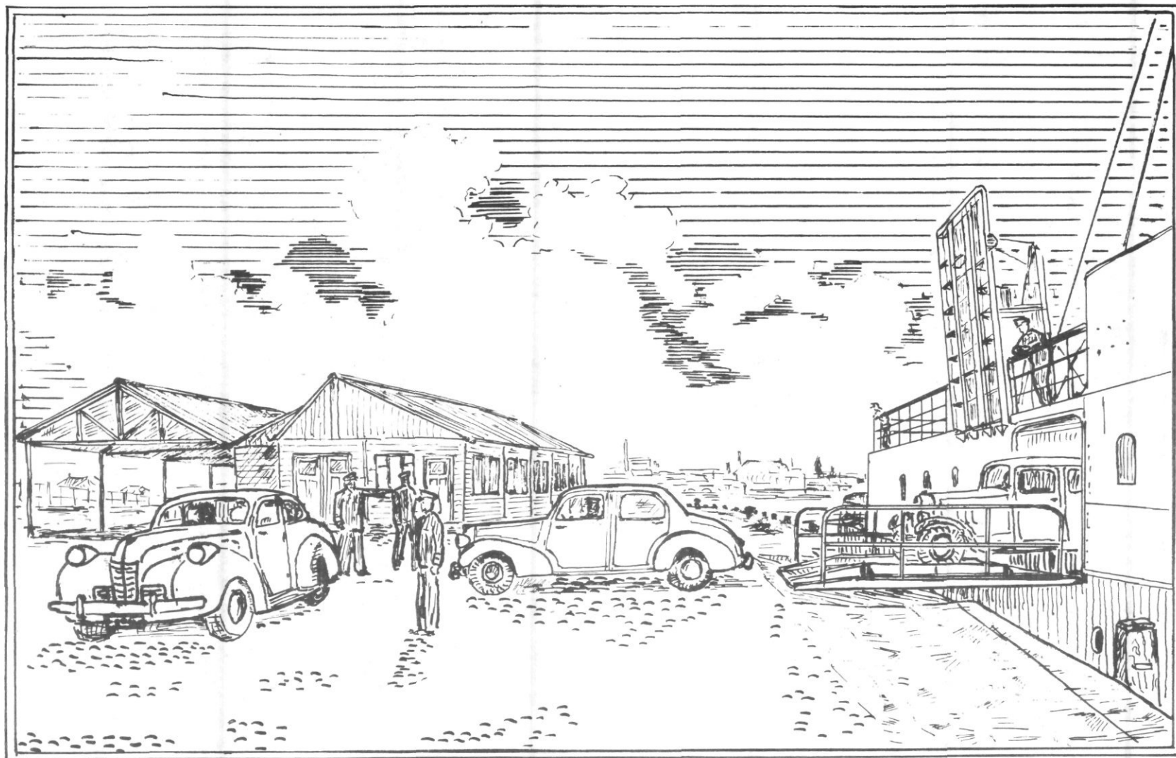
16. 1938 - Oosteroever der haven Oostende - lossen van de carferry "Londen-Istanbul". Bemerkt links de voorlopige gebouwen van de carferrydienst.
