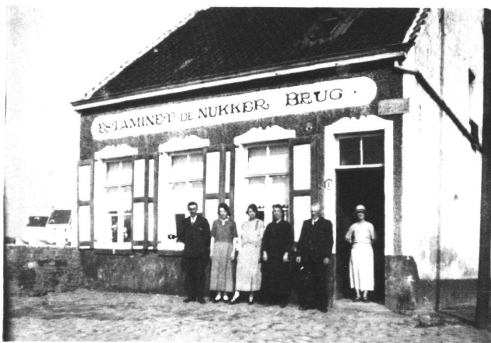
25. Deze foto van 1921 toont ons estaminet „De Nukkerbrug”, gebouwd in 1893 ten behoeve van de werklieden van de steenbakkerij Billiouw, die toen de Nukkerwijk aan het uitbakken waren. Het werd gesloopt in 1952, bij de verbreding van de Nukkerbrug. Voor het café staat de uitbater, E. Bossier, met zijn gezin. In het deurgat de eigenares van de gekende winkel „La ville de Londres” uit Oostende, die toentertijd iedere zondag kwam hengelen in de Noord-Ede.
