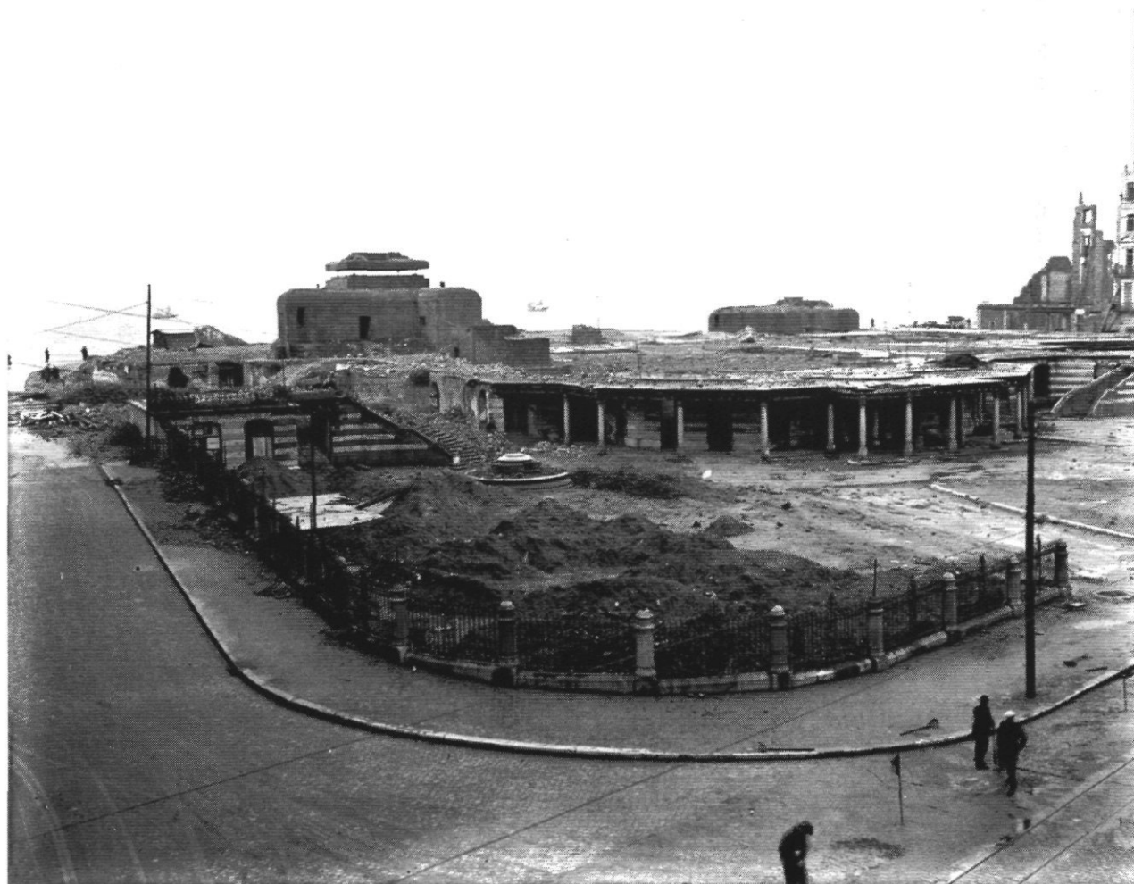
- Na de kaalslag een stuk Atlantikwall op het terrein van het gesloopte Kursaal. (collectie Freddy Hubrechtsen).
